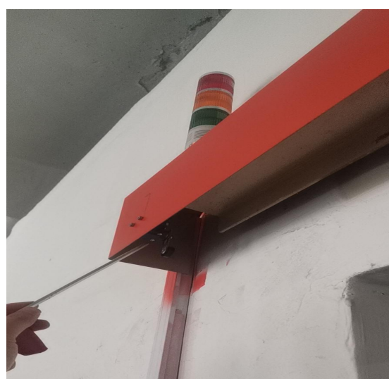
照片 30 1#排气室门机连锁
