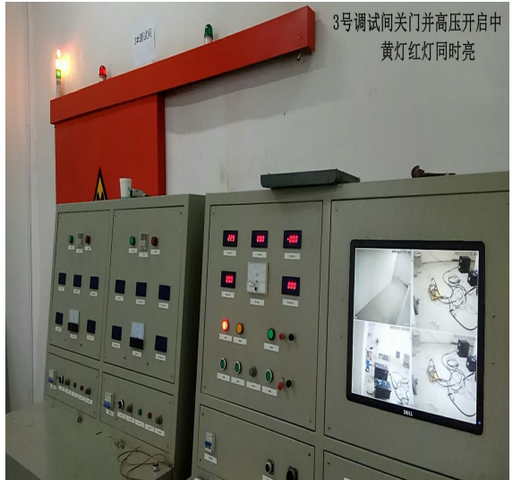
照片 9 3#调试间防护门及指示灯、监控视频
