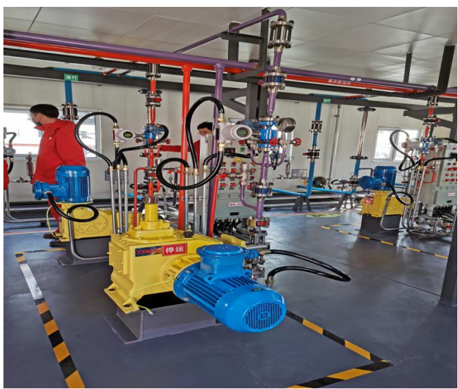
碱表注入及三元混合配注装置：3#碱泵
