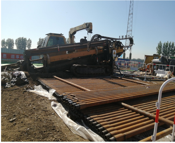
穿越开工导向孔开钻
