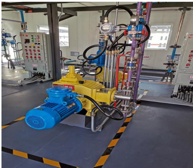
碱表注入及三元混合配注装置：2#碱泵
