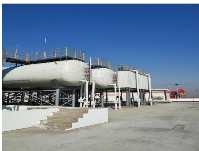
配注站：储水罐、聚合物母液连续熟化装置
