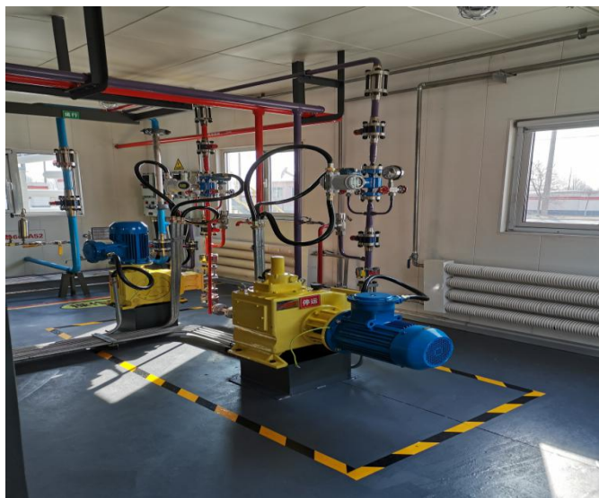
碱表注入及三元混合配注装置：5#碱泵
