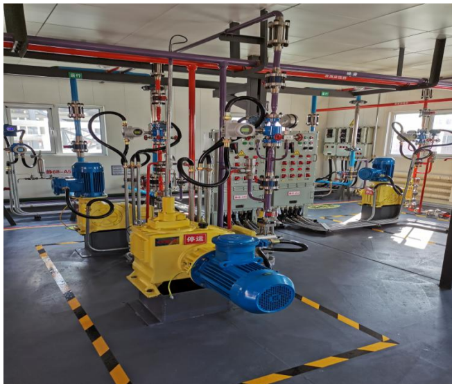
碱表注入及三元混合配注装置：4#碱泵
