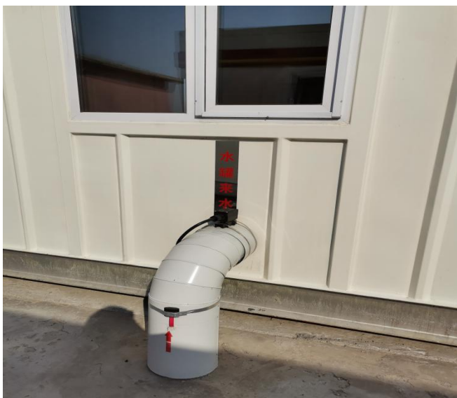
聚合物分散溶解装置：水罐来水
