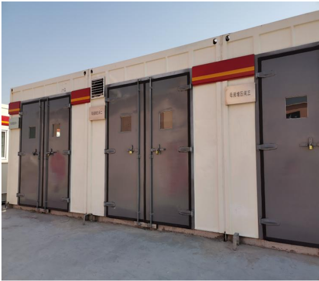
高压掺水及母液增压装置
