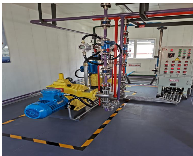
碱表注入及三元混合配注装置：1#碱泵
