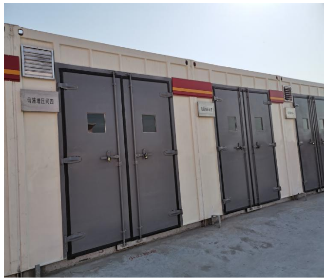
高压掺水及母液增压装置
