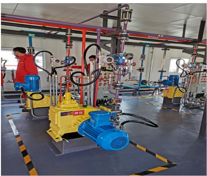
碱表注入及三元混合配注装置：3#碱泵
