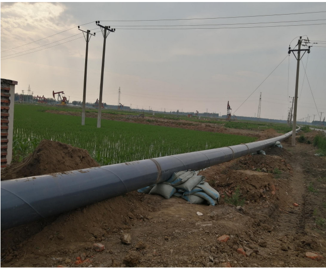
定向钻穿越套管组对焊接完成
