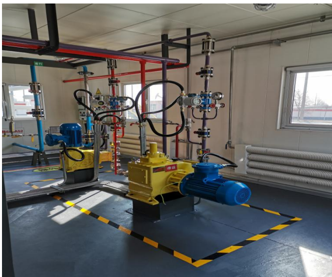
碱表注入及三元混合配注装置：5#碱泵
